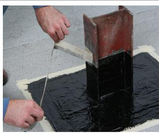
Se usa 1/2 envase de MBR Flashing Cement para terminar el detalle.
